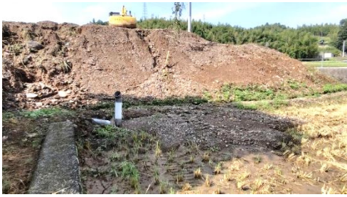
水田に流れ込んだ盛土の土砂
